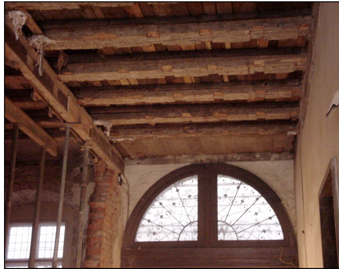
Bild 19: Unteransicht der historischen Decke während des Abbinden des Betons mit Montageabstützung
