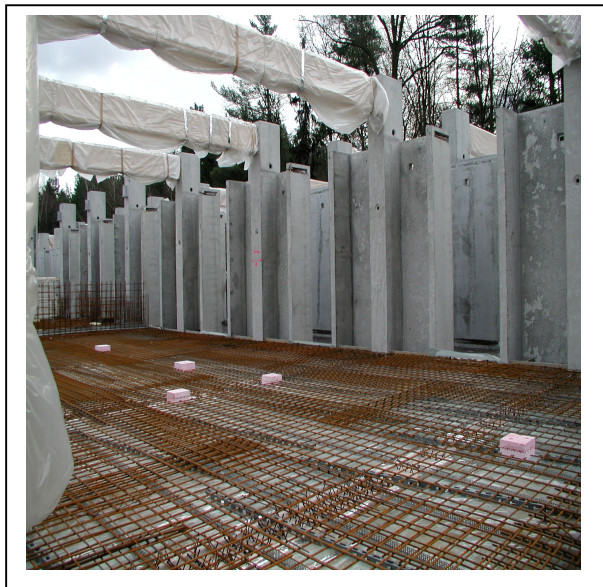
Bild 22: Stahlbeton- Platte vor dem Betonieren und fertiggestelltes Gebäude
